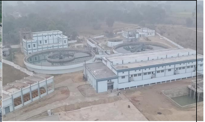
80 MLD WTP, Unnao
