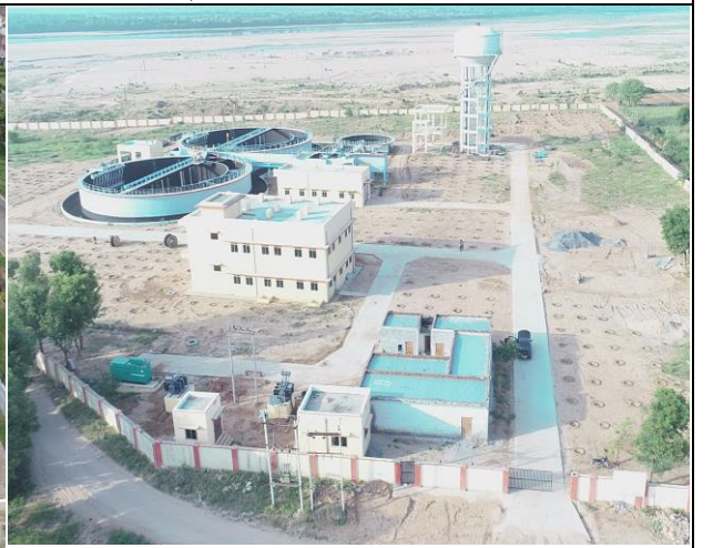
16 MLD STP, Tonk
