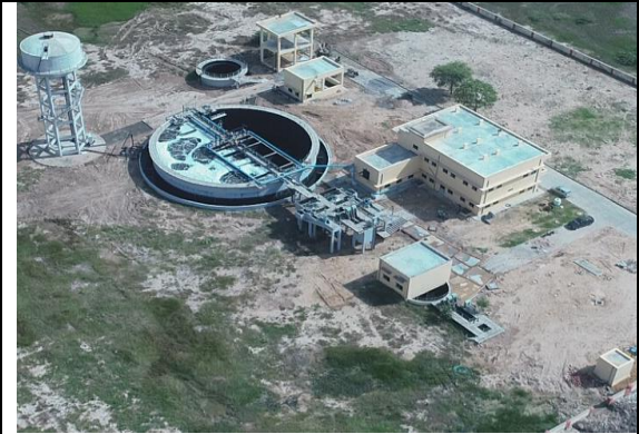
4 MLD STP, Tonk
