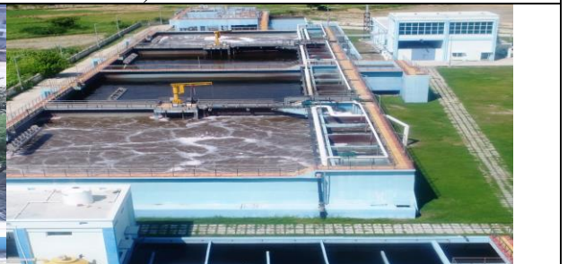
24 MLD STP, Etah
